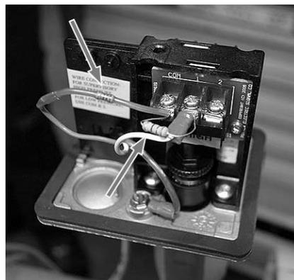
**Рис. 2** Пример установки сопротивлений (резисторов) в корпусе реле давления
