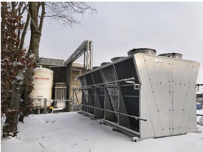
使用乾式冷卻器作為冷凝器，一般需要保持冷凝器內穩定的液體流速及最低溫度。若乾式冷卻器是用作自然冷卻器，泵裝置設計便可在不需使用風扇冷卻的低負荷情況下，取代溫度控制功能。
