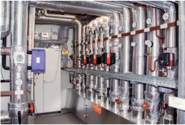
Heizungskreise mit Magna3-Pumpen in der Heizungszentrale des Neubaus Niederhof
