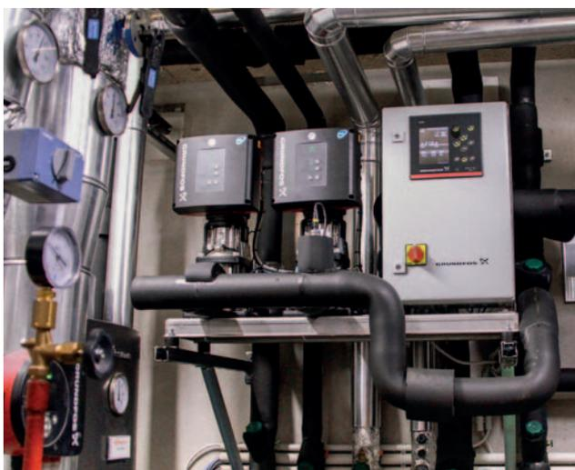
Druckerhöhungsanlage Grundfos Hydro MPC-E mit zwei geregelten Kreiselpumpen und Steuer- und Regeleinheit CU 352 (Bild: Hasenauer Anlagenbau)
